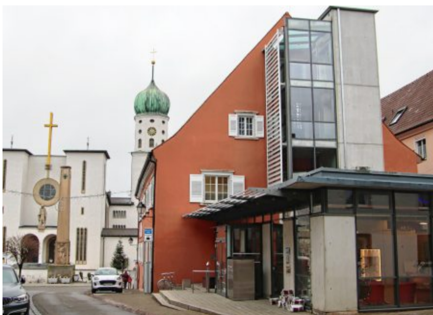
Das alte Forstamt wurde vor rund 20 Jahren zum Kulturzentrum ausgebaut. Nun hat die Stadt ein weiteres Gebäude in der Oberstadt zur Erweiterung gekauft. BILD: DOMINIQUE HAHN
